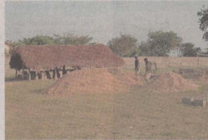
Lavori in corso per la nuova scuola
